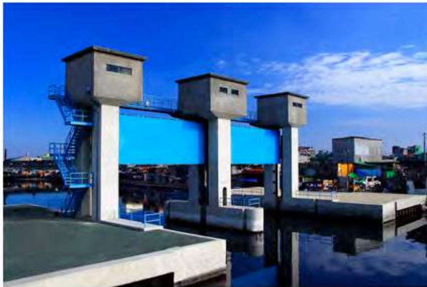
Navotas Floodgate R-10, Navotas City (2 x 12.0 m x 4.4 m)
